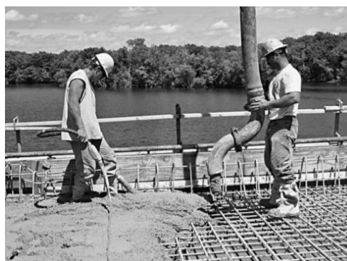
Figura 4: Trabalhadores colocando concreto em uma plataforma de ponte que possui aço de reforço revestido com epóxi ( Portland Cement Association )
